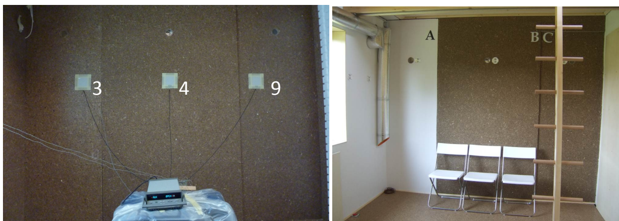
Merilniki toplotnega toka, nameščeni na površino posameznega segmenta testne stene in njen izgled v končani Celici
